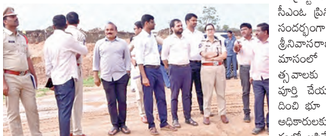
ఎదుక్కేషన్ హబ్ నిర్మాణ పనులు పరిశీలిస్తున్న కలెక్టర్,ఎస్పీ
